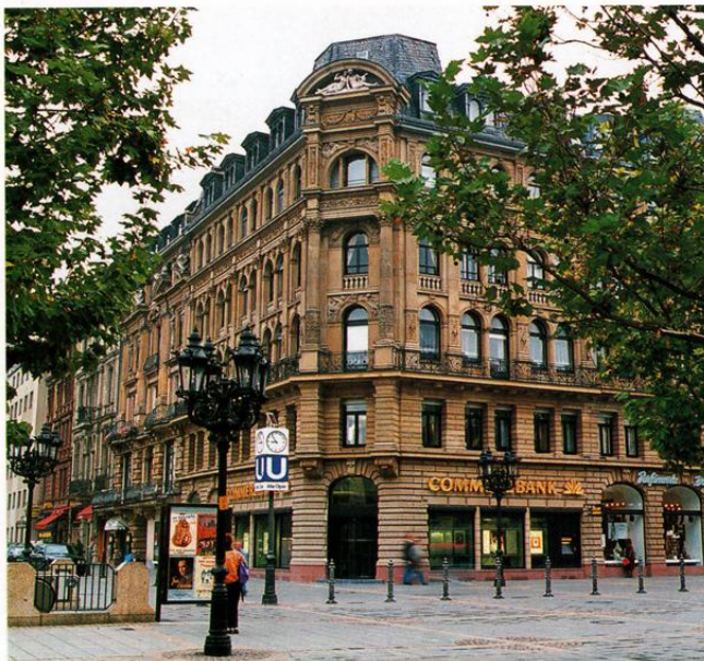
Frankfurt (Main), Zweigstelle Am Opernplatz
