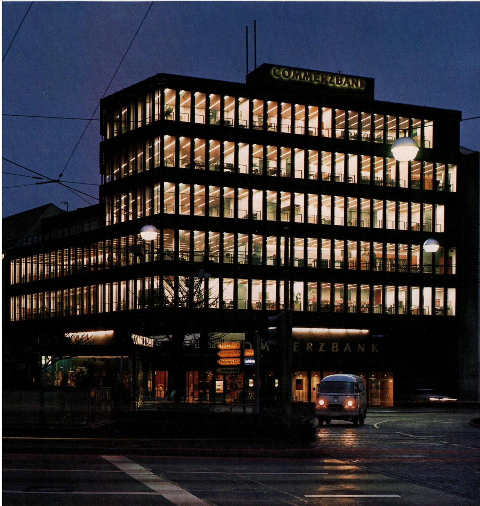
Das Neubau- und Renovierungsprogramm schreitet planmäßig voran. – Unser Bild: das neue Domizil der Filiale Bielefeld.
