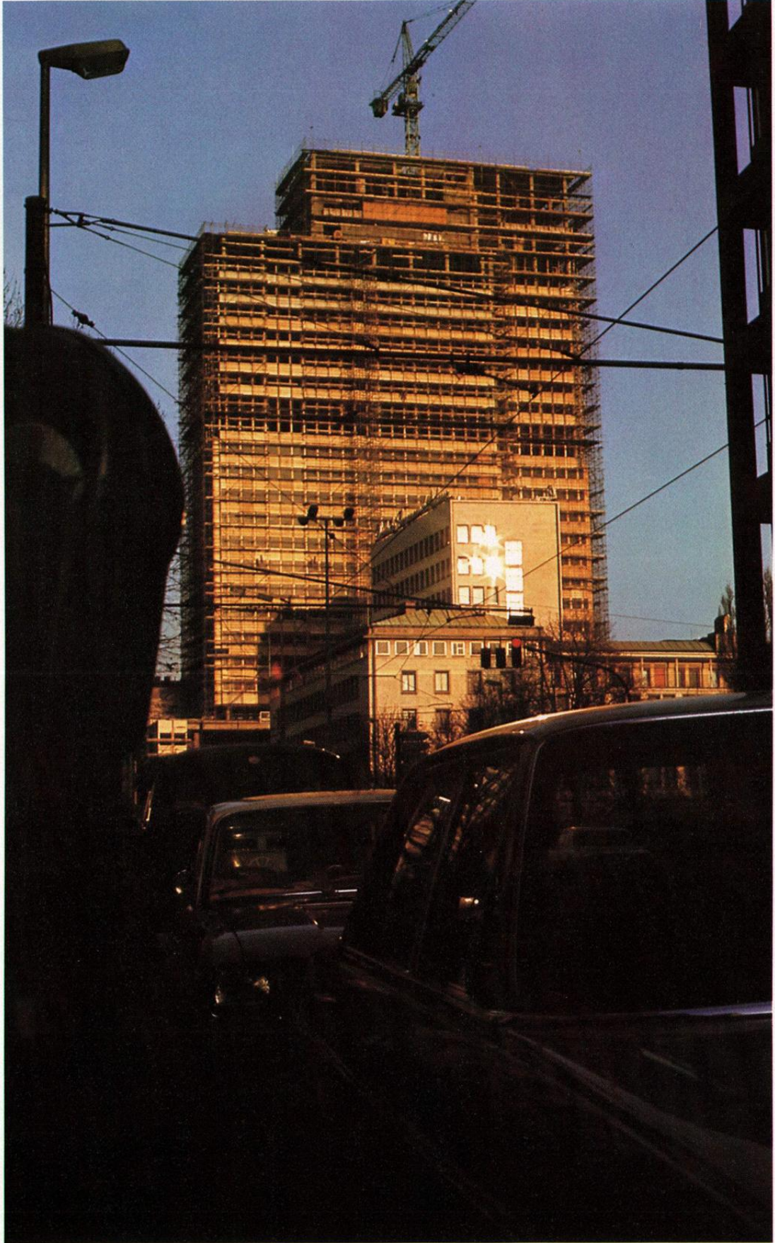
Das Hochhaus unserer Zentrale Frankfurt wurde Ende 1972 im Rohbau fertiggestellt.
