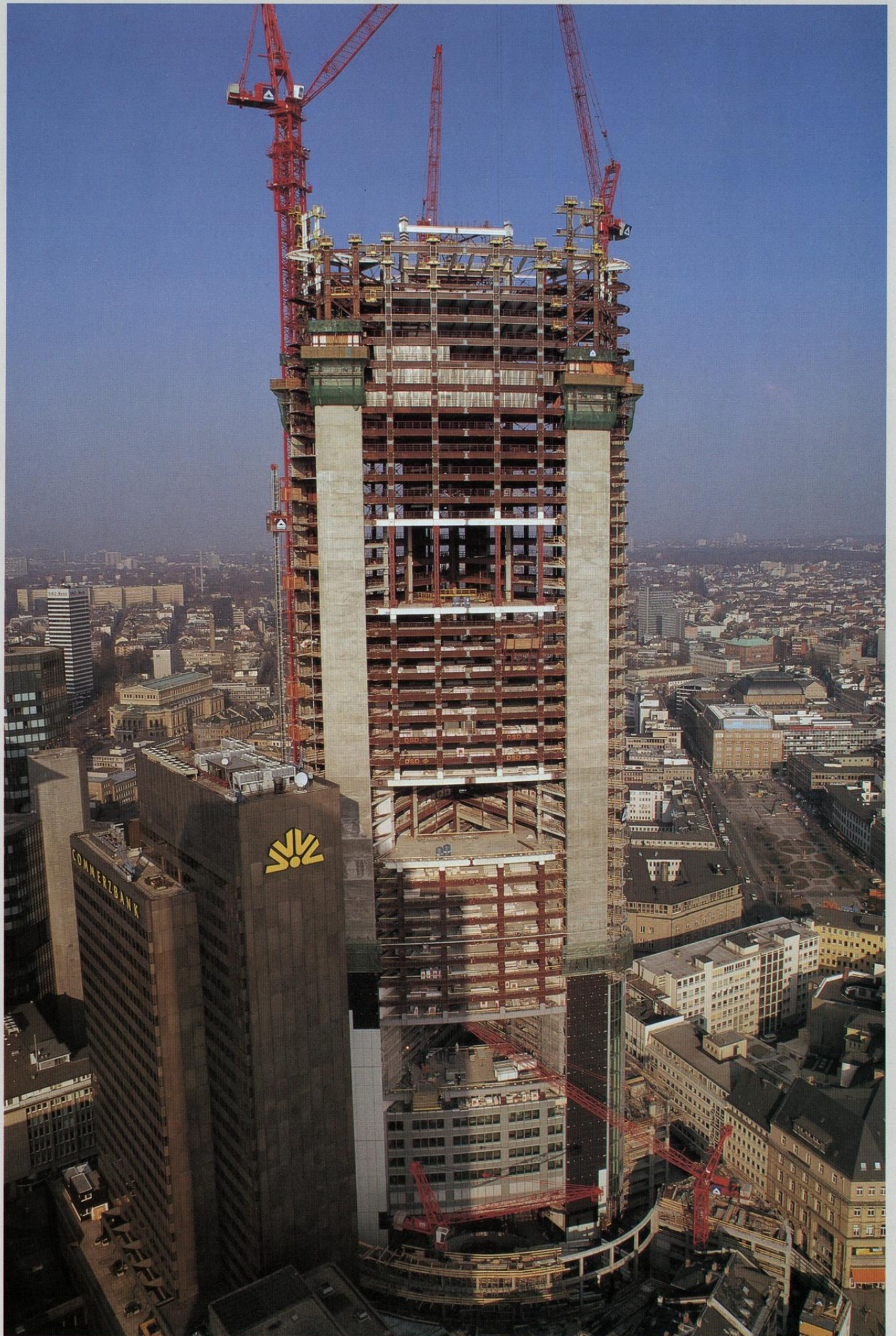
Baufortschritt am 22. Januar 1996.
